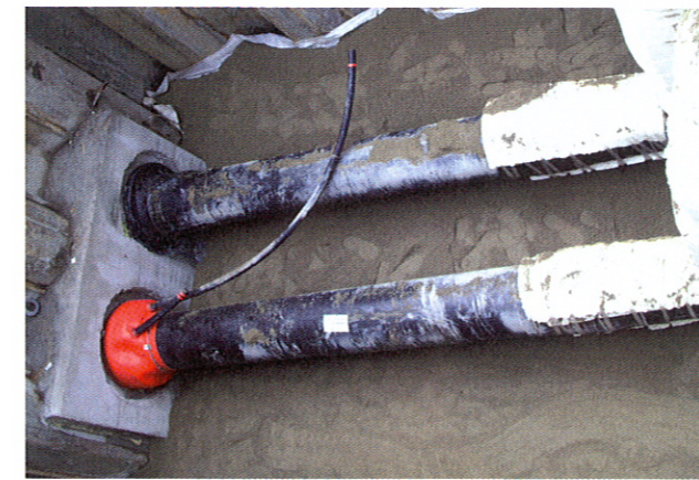
Abb. 6 Vor dem Verfüllen der Pressgrube wurden die Rohrleitungen in Fließ eingepackt.
